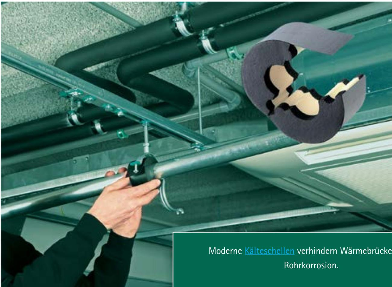
Moderne [Kälteschellen](#) verhindern Wärmebrücken und Rohrkorrosion.
