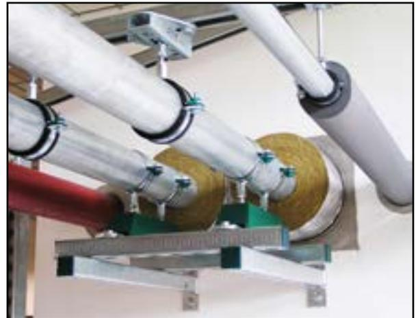
**Eine Längenänderung eines Rohres tritt auf, weist die Rohrleitung im Betrieb andere Temperaturen auf als während der Montage.**
