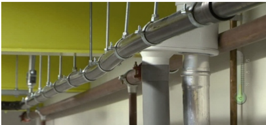
Bild 1: Rohr bei geringer Längenausdehnung
