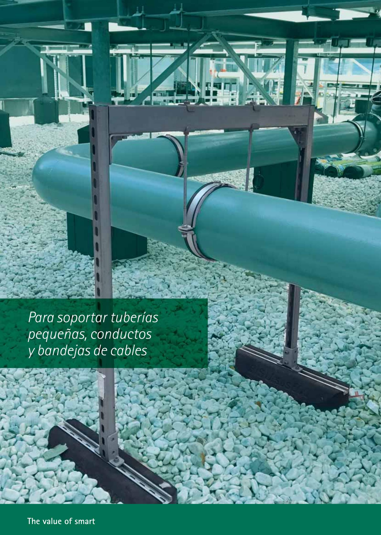
*Para soportar tuberías pequeñas, conductos y bandejas de cables*
