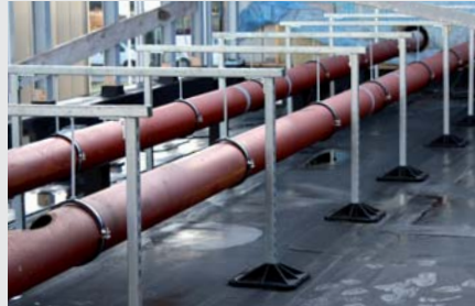
Data Center i Apeldoorn (NL)
