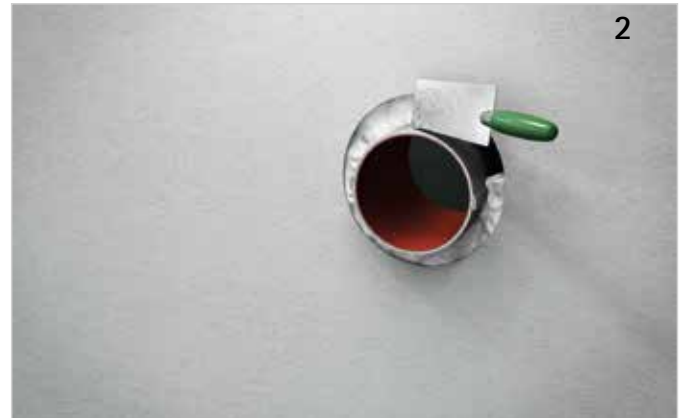
Ringspalt mit Pacifyre® FPM Brandschutzmörtel verschließen.
