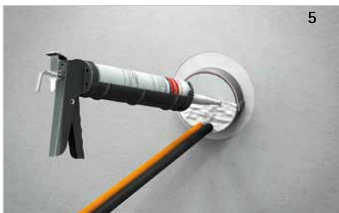
Stopfen komplett in Dicke \geq 2 mm (TSD \geq 1 mm) mit FLAMMOTECT-A versiegeln.
