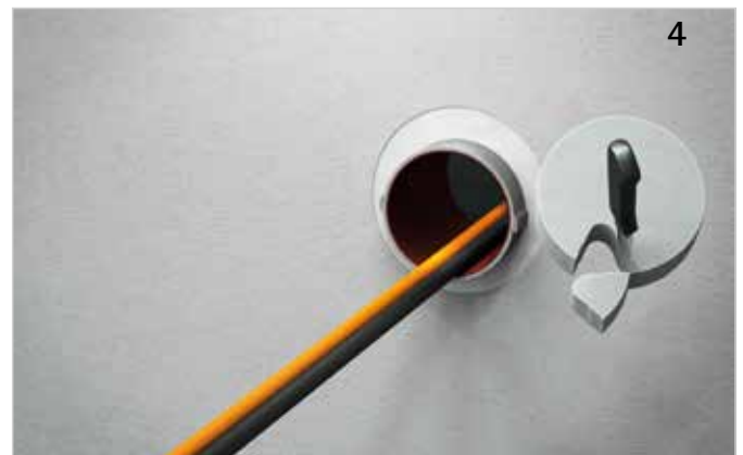
Stopfen entsprechend zuschneiden und beidseitig einpassen.
