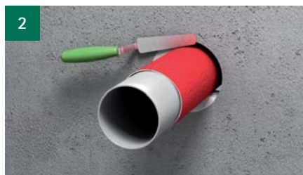
2 Zaistite dymotesné utesnenie prstencového otvoru (napr. BIS Pacifyre® FPM Protipožiarnou maltou alebo T angit FP 430 Protipožirnym akrylátom).
