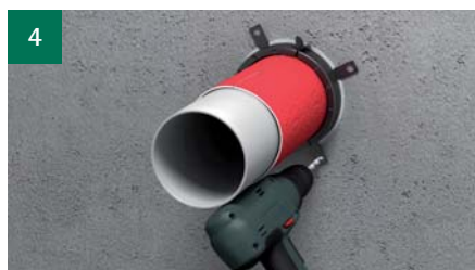
4 Vyvrtajte otvory (ohýbanie a posúvanie upevňovacích krídeliek je dovolené).
