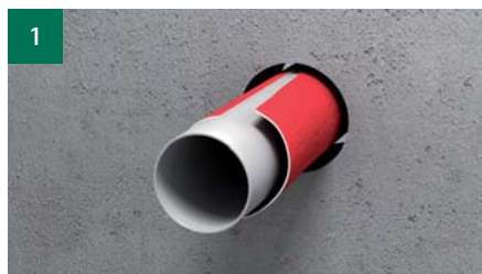
1 Nainštalujte potrubie a prípadne protihlukovú izoláciu.
