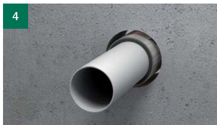
Vsuňte manžetu do otvoru a vycentrujte ju.
