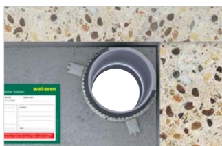
Vhodné pro rohové priechody (2/3 protipožiarnej manžety). Vzdialenosť medzi múrom a potrubím ≤ 10 mm.
