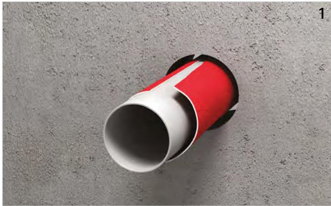
Rohrleitung (ggf. mit PE-Schallschutzschlauch) durchführen.
