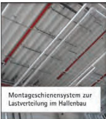
Montageschienensystem zur Lastverteilung im Hallenbau
