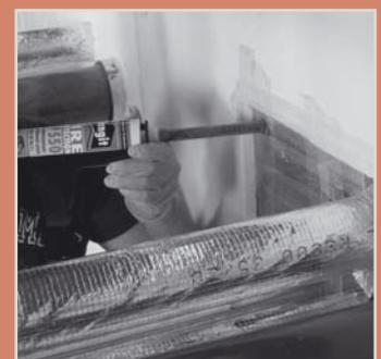
Einfach im oberen Bereich der Schottfläche einspritzen – FP550 expandiert selbsttätig bis in alle Hohlräume
