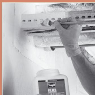
Abschlussbeschichtung von Kabeln und Kabeltrassen bis 150 mm über das Schott hinaus
