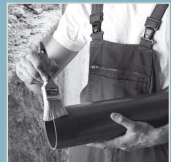
Der Rohrklebstoff wird idealerweise mit einem weichen Pinsel aufgetragen.
