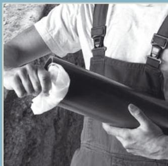
Die Reinigung und Aktivierung der Klebeflächen ist unbedingt notwendig für die sichere Verklebung
