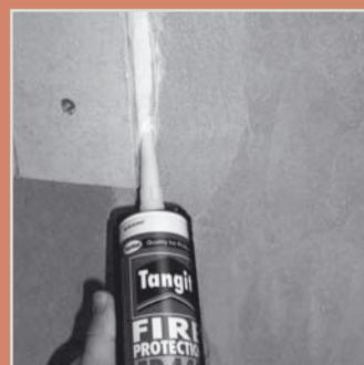
Zusätzlicher Einsatz von FP440 an Deckenschotts zum Anschluss der Beplankung an den Baukörper
