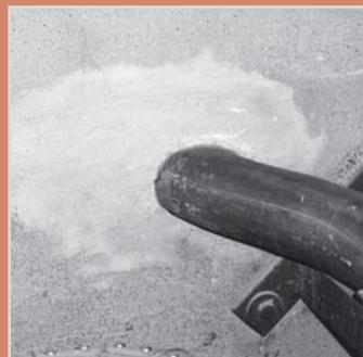
Kernprodukt für das klassische Mörtelschott. FP300 ist verarbeitbar von Hand oder mit der Mörtelpumpe
