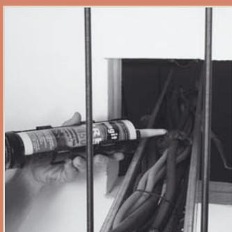
Zusätzlicher Einsatz von FP450 an Kabelbündeln und Kabeltrassen
