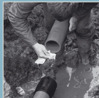
Systembestandteil sämtlicher PE-Rohrverschweißungen, z. B. beim Einsatz von Elektroschweißmuffen
