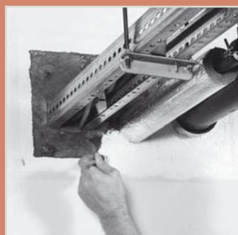
Abschlussbeschichtung auf FP550 als Systembestandteil sämtlicher Abschottungen
