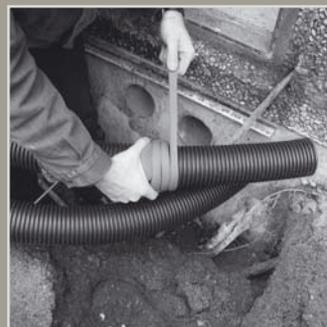
Dichtschlauch M4082 um das Rohr legen...
