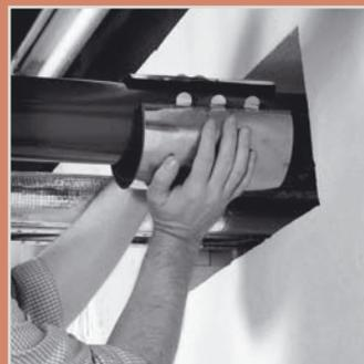
Durchsteckmanschette zur werkzeuglosen Montage von einer Seite aus: Anlegen – Einschieben – Fertig!
