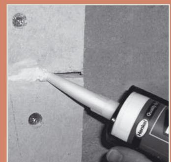
Abdichten der Plattenstöße an der Beplankung eines Deckenschotts
