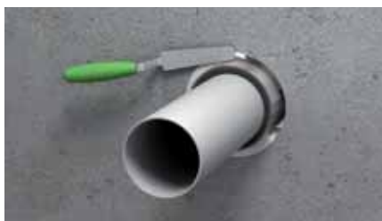
5. Wypełnij zaprawą cementową lub gipsową
