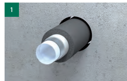
Buis installeren en eventueel isolatie aanbrengen.
