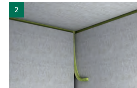
Aanbrengen steenwol en opschuiven in de voeg.
