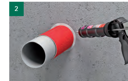
Restvoeg rookdicht afdichten (bijv. met Tangit FP 430 Brandwerende Acrylaat Kit of met Pacifyre® FPM Brandwerende Mortel).
