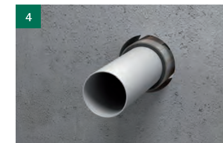
4 Plaats de manchet in het midden van de doorvoering (dient aan beide zijden minimaal 5 mm uit te steken).
