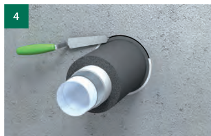
Restvoeg rookdicht afwerken (bijv. met Tangit FP 430 Brandwerende Acrylaat Kit of met Pacifyre® FPM Brandwerende Mortel).
