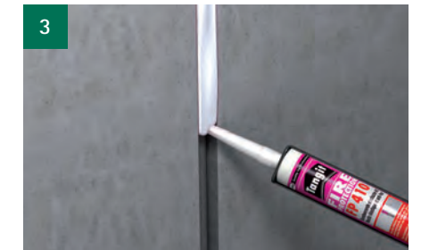
Aanbrengen Tangit FP 410 Brandwerende Elastische Kit en gladstrijken na besproeien met water met zeepoplossing.
