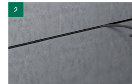
Aanbrengen steenwol en opschuiven in de voeg (verhouding breedte:diepte = 1:1).
