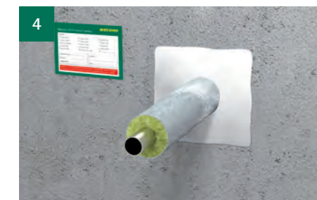
Plaats transparant afdichtingstape. Dicht de resterende opening rond de onbrandbare isolatie af met Tangit FP 550 2-c Brandwerend Schuim tegen een rugvulling van losse minerale wol.
