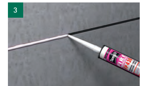
Aanbrengen Tangit FP 430 Brandwerende Acrylaat Kit aan beide zijden van de wand.
