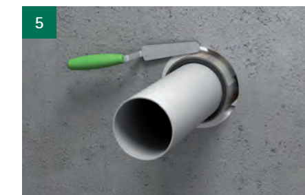
5 Werk de resterende opening af met brandwerend schuim, kit of mortel.
