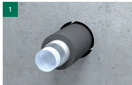
Buis installeren en eventueel isolatie aanbrengen.
