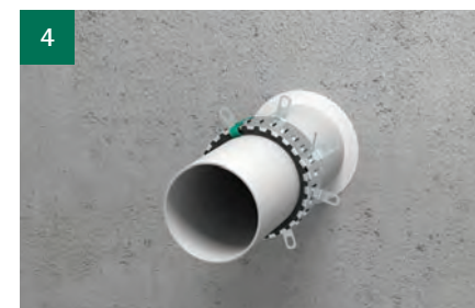
Manchet sluiten door de sluitstrip van binnen naar buiten door het tweede gat te steken en terug te buigen.
