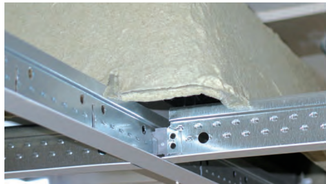
De kap is bij de hoeken voorzien van inkepingen, zodat hij op eenvoudige wijze stevig over de profielen van het verlaagde plafond geplaatst kan worden.
