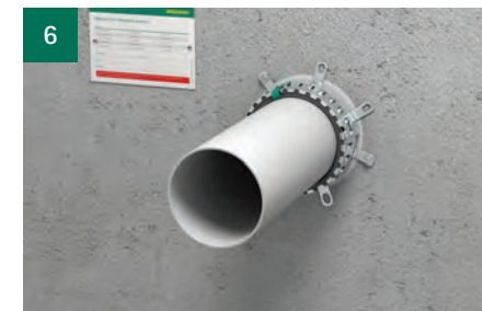
Vul de Pacifyre® ID-Kaart in en plaats deze naast de doorvoering op de wand.
