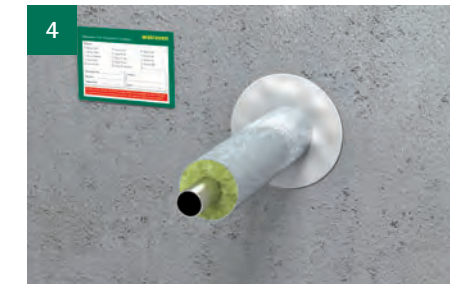
Dicht de resterende opening rond de onbrandbare isolatie af met brandwerende acrylaat kit tegen een rugvulling van losse minerale wol.
