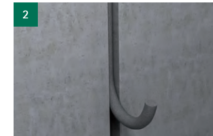
Aanbrengen rugvulling (verhouding breedte:diepte = 1:1).
