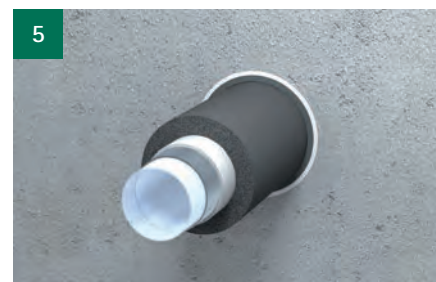
Inspectie van de doorvoering.
