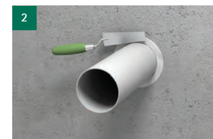
Restvoeg rookdicht afwerken (bijv. met Tangit FP430 Brandwerende Acrylaat Kit of met Pacifyre® FPM Brandwerende Mortel).
