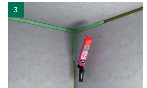
Aanbrengen Tangit FP 100 1-c Brandwerend Schuim aan beide zijden van de wand.
