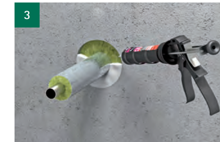
Dicht de resterende opening rond de onbrandbare isolatie af met brandwerende acrylaat kit tegen een rugvulling van losse minerale wol.
