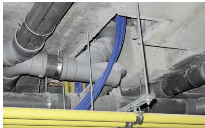
Sparing / Vuilwaterafvoer / Communicatietechniek / Gas
