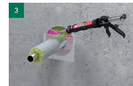
Plaats transparant afdichtingstape. Dicht de resterende opening rond de onbrandbare isolatie af met Tangit FP 550 2-c Brandwerend Schuim tegen een rugvulling van losse minerale wol.
