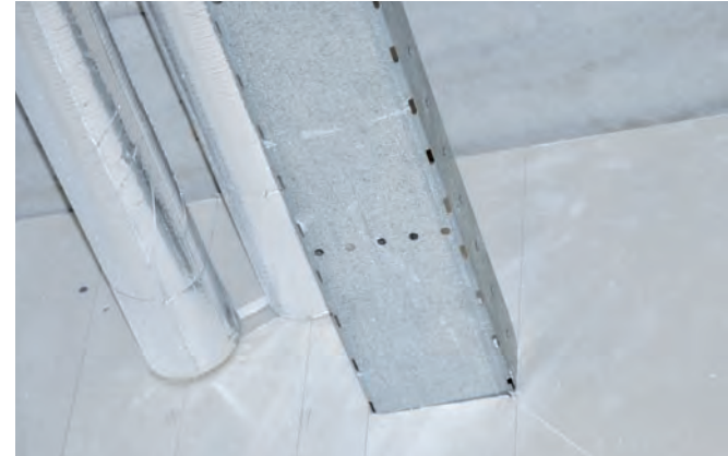
Elektrotechnische installaties / Koeling
