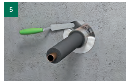
5 Werk de resterende opening af met Tangit FP Brandwerend Schuim, Kit of Mortel.
