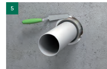
Werk de resterende opening af met brandwerend kit, schuim of mortel.
