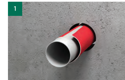
Buis installeren en desgewenst geluidsisolatie monteren.
