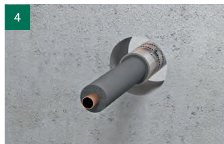
4 Plaats de manchet in het midden van de doorvoering (dient aan beide zijden 5 mm uit te steken).
