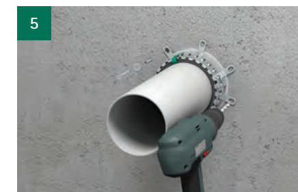
Boren (de bevestigingslippen mogen eventueel ook 90° omgebogen en ingemetseld worden in de brandwerende mortel!).
