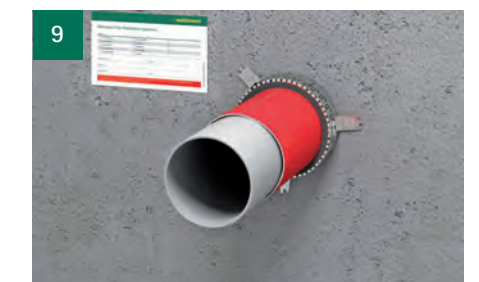
Vul de Pacifyre® ID-Kaart in en plaats deze naast de doorvoer op de wand.
