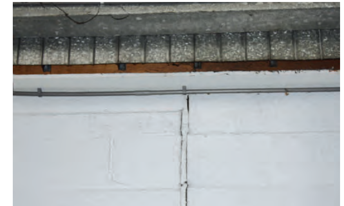
Dilatatievoegen / Bouwnaden
