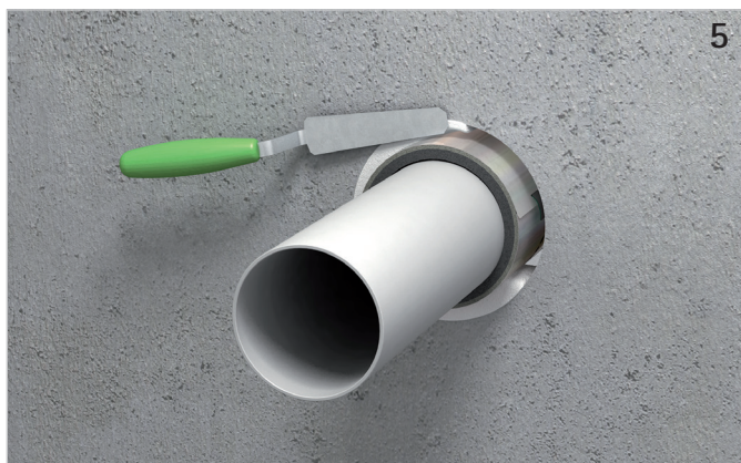
Restspalt rauchgasdicht (mit Tangit FP 550 oder Pacifyre® FPM Brandschutzmörtel) verschließen.
