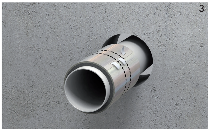
Ohne Werkzeug mit Hilfe der Laschen verschließen.
