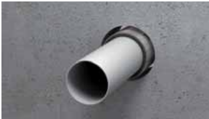
4. Просунути гільзу у стіновий отвір
