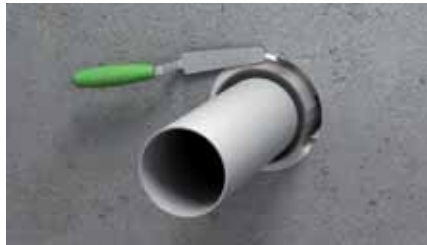
5. Заповнити отвір спеціальною піною чи будівельним розчином
