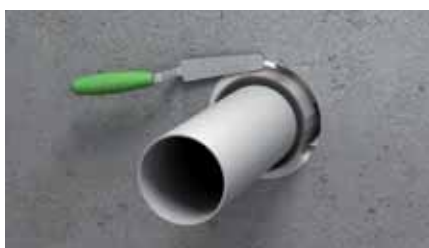
5. Colmatez l'espace entre le manchon et la paroi à l'aide d'enduit acrylique, de mousse ou de mortier
