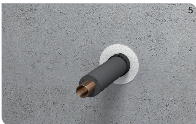
Ggf. Kontrolle der Abschottung.
