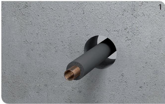
Rohrleitung mit Dämmung installieren.
