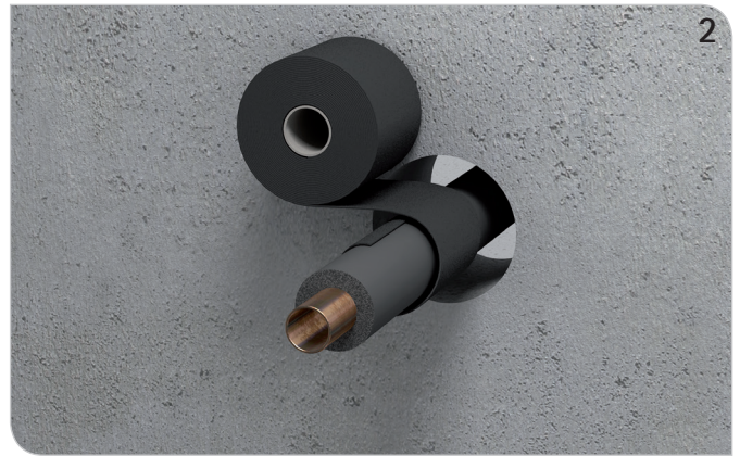
Rohrummantelung um die Dämmung legen (Lagenzahl beachten!) und Überlappung (ca. 20 mm) verkleben.
