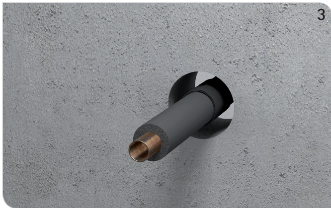
Rohrummantelung in die Bauteilöffnung schieben (Überstände beachten).
