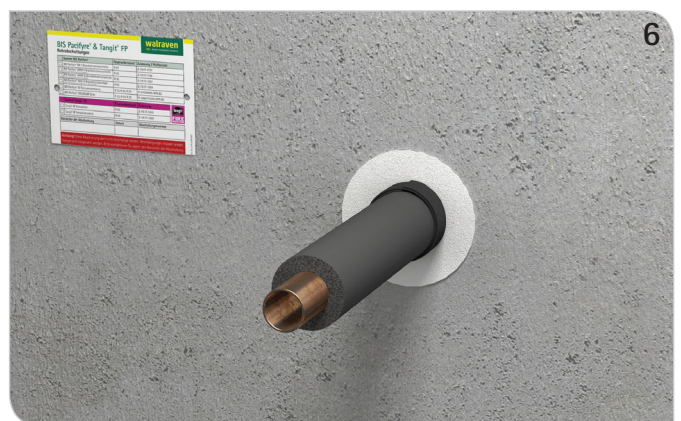
Das Kennzeichnungsschild ausfüllen und neben der Abschottung anbringen.
