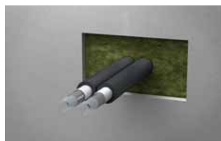
3. Sprawdź, czy odległość od powierzchni ściany do płyty wynosi 25mm.
