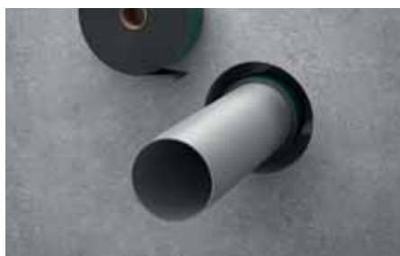
2. Owiń rurę wymaganą ilością warstw Taśmy ogniowej Walraven Pacifyre® FPW.
