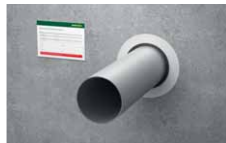
6. Oznakuj przejście: naklej tabliczkę Walraven Pacifyre® ID i wypełnij informacje.
