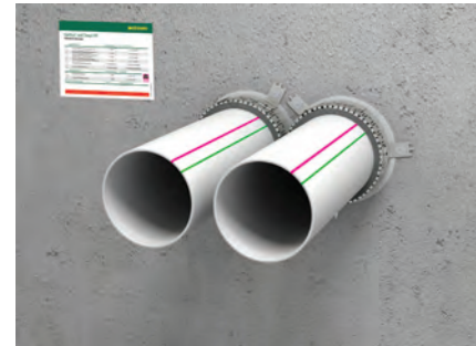
Nullabstand bei ungedämmten Rohren
