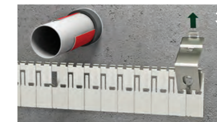
Befestigungspunkt für Haken festlegen, durch Aufbiegen der Nasen des Metallbandes um 90°
