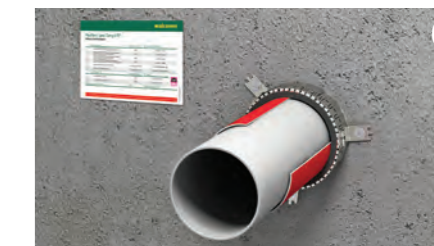
Andübeln der Haken mit dem mitgelieferten Befestigungsset. Das Kennzeichnungsschild ausfüllen und neben der Abschottung anbringen.
