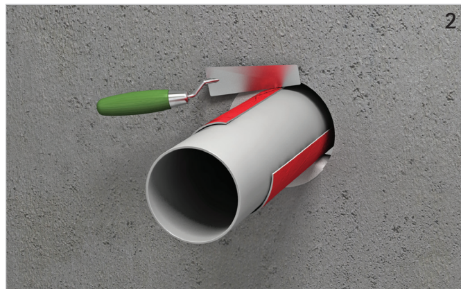
Restspalt rauchgasdicht (mit z. B. Pacifyre® FPM Brandschutzmörtel) verschließen.
