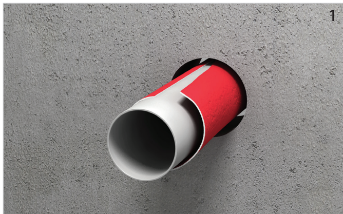
Rohrleitung (ggf. mit PE-Schallschutzschlauch) durchführen.
