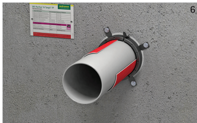
Das Kennzeichnungsschild ausfüllen und neben der Abschottung anbringen.
