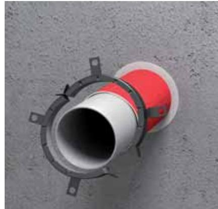
3. Choisissez le collier adapté au diamètre du tube. Dans les configurations difficiles, il est possible d'utiliser un collier d'un diamètre supérieur (maximum 3 diamètres au-dessus du diamètre normal)
