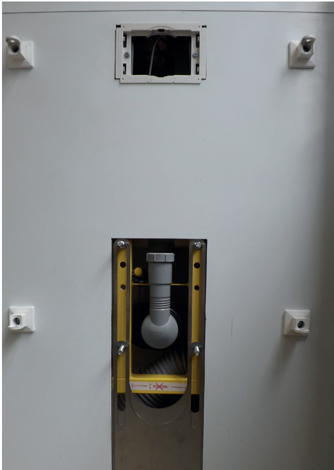
Vier Stück Wellenhalter montieren
