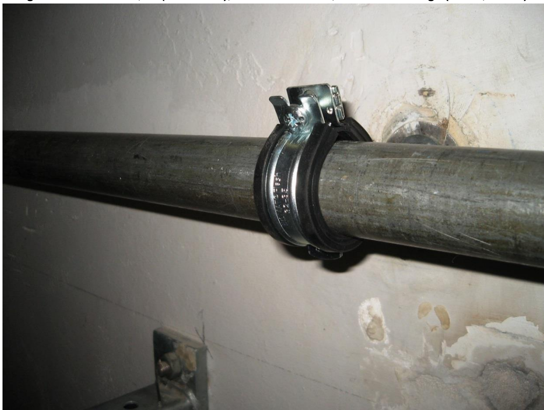
Bild 1: Messung 2: BISMAT® Flash, 1" (32 - 35mm), Anschluss M8/10, mit EPDM-Einlage (20 x 4,20 mm)
