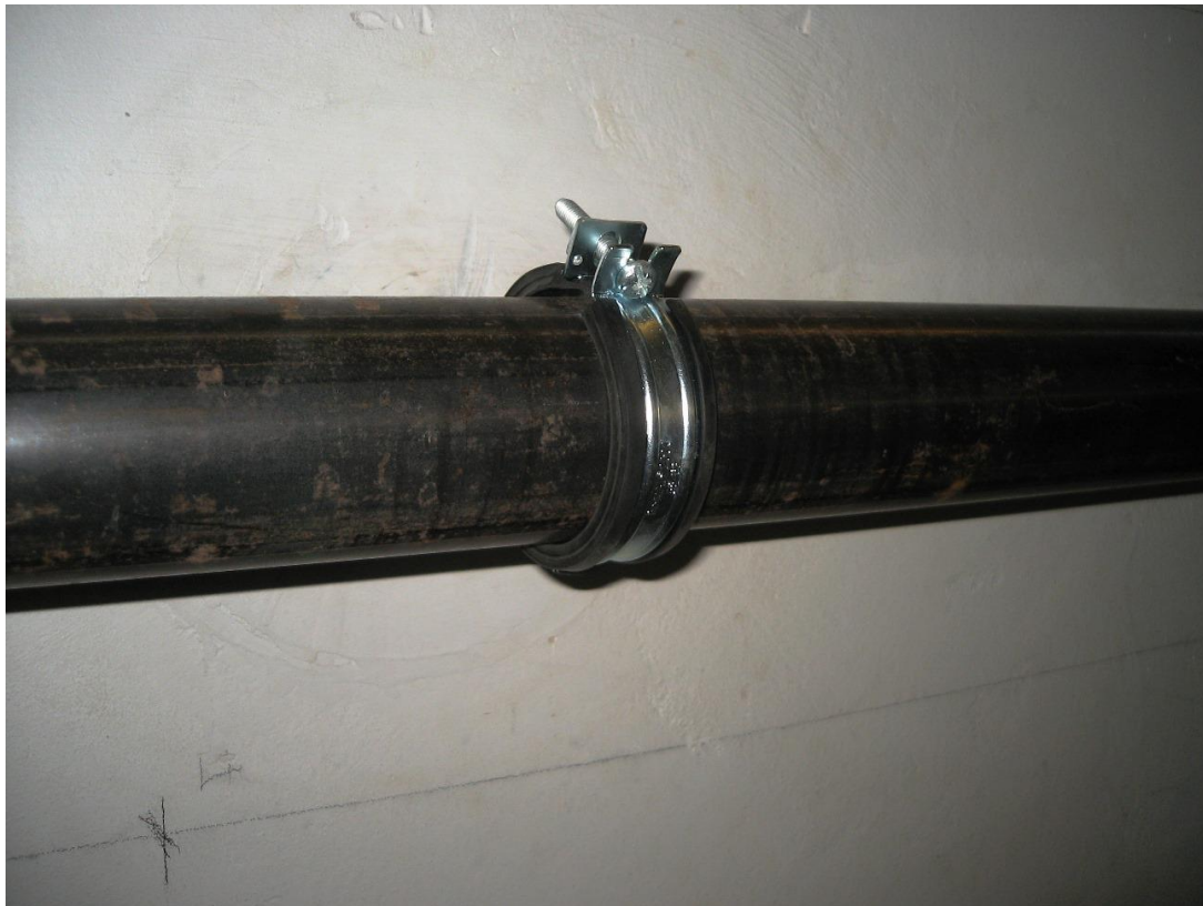
Bild 1: Messung 3: BISMAT® 2000, 2" (58 - 63mm), Anschluss M8/10, mit EPDM-Einlage (20 x 4,20 mm)
