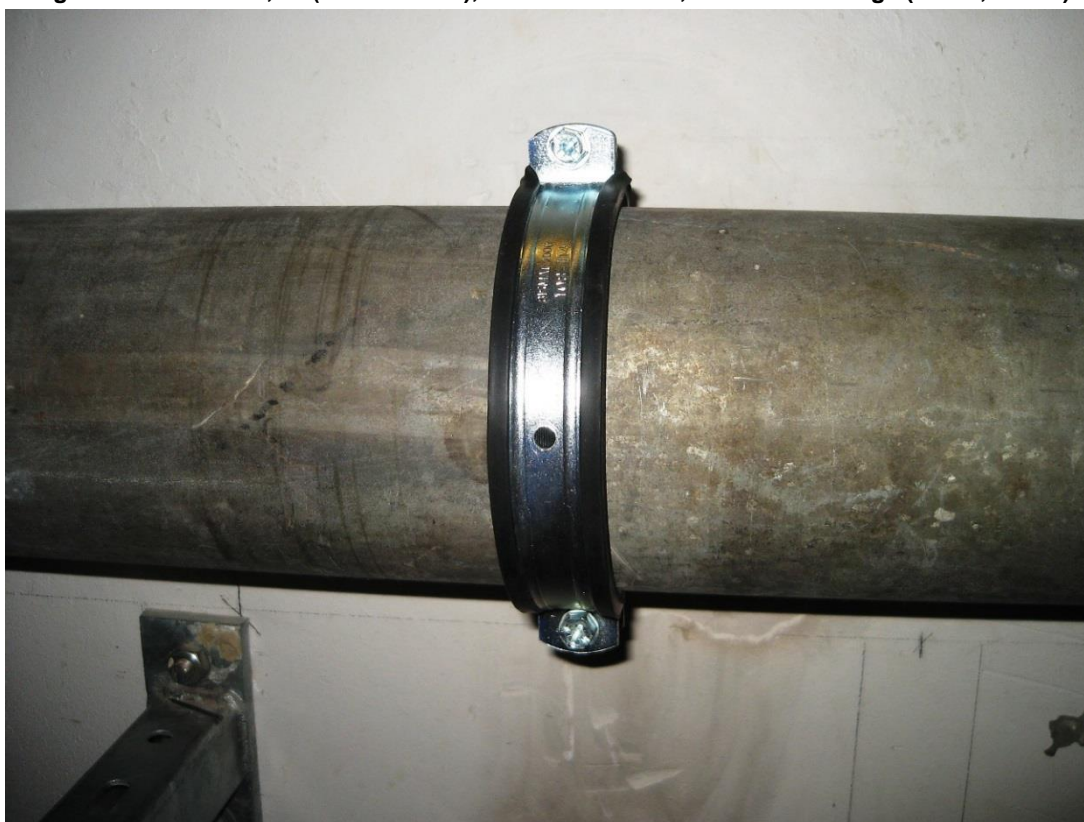
Bild 2: Messung 4: BISMAT® 2000, 4" (108 - 114mm), Anschluss M8/10, mit EPDM-Einlage (25 x 4,00 mm)
