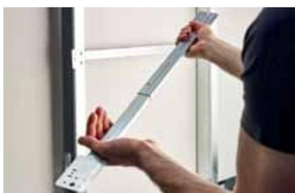
2. Los soportes pueden extenderse para ajustarse entre montantes que se encuentren con una separación de 40 a 60 centímetros.
