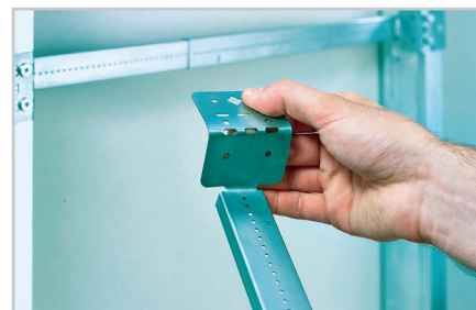
3. Wandplatten entsprechend der baulichen Anforderung umbiegen und befestigen.
