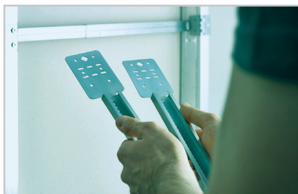
1. Montageschiene wird als vormontiertes Paar angeliefert.
