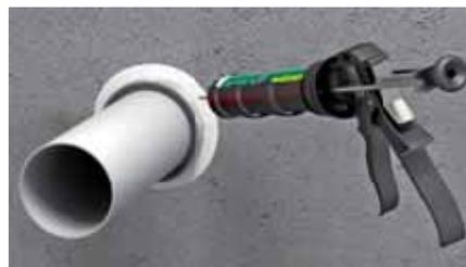
2. Poner algo de lana mineral como relleno, rellenar 25 mm de profundidad con Acrílico o Silicona selladora.
