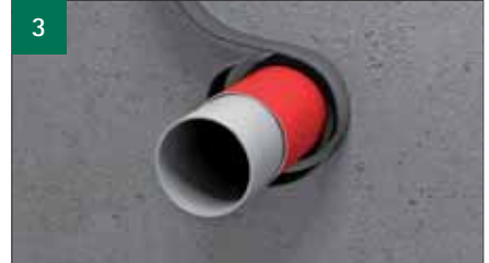
3 Strimlen (eller isoleringen) vikles omkring røret (se antallet af påkrævede lag*). Sæt fast med et overlap på 15 mm.
