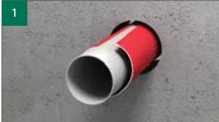
1 Installer røret og anvend isolering om nødvendigt.
