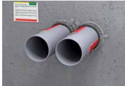
Mulig nulafstand mellem manchetterne (isolerede rør).
