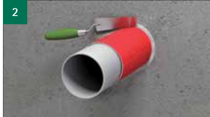
2 Sørg for at fugen rundt om røret er forsejlet korrekt og røgtæt med BIS Pacifyre® FPM Brandsikrings Cement eller lignende.
