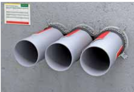
Multi gennemføringer. (maks. 3 rør til 1 Brandkrave). Afstand mellem rør \leq 15 mm.
