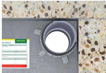
Velegne til gennemføringer i hjørner (2/3 brandkraver). Afstand mellem væg og rør \leq 10 mm.
