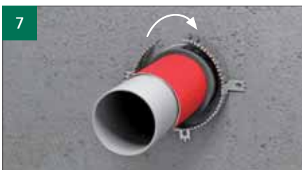
7 I slutningen af båndet af rustfrit stål bøjes 2 "tapper". Placer enderne over hinanden og fold "tapperne" tilbage, for at låse stål båndet.
