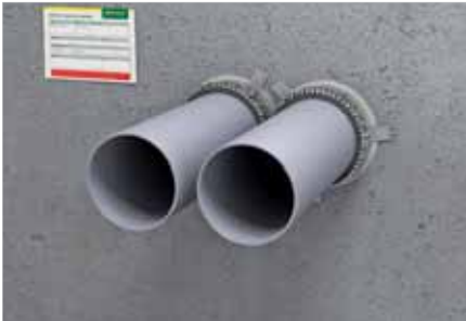
Mulig nulafstand mellem manchetterne (uisolerede rør).
