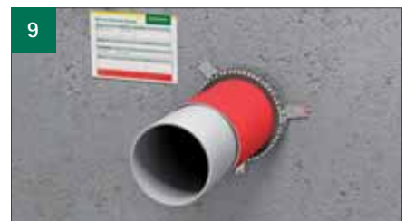
9 Påfør et BIS Pacifyre® ID-Kort på væggen / gulvet til identifikation af sagkyndige inspektører.
