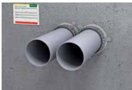
Nulová vzdálenost mezi manžetami (neizolované potrubí).
