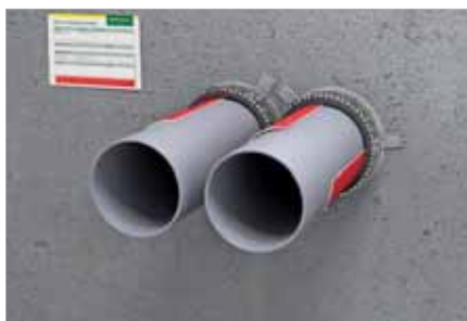
Nulová vzdálenost mezi manžetami (izolované potrubí).
