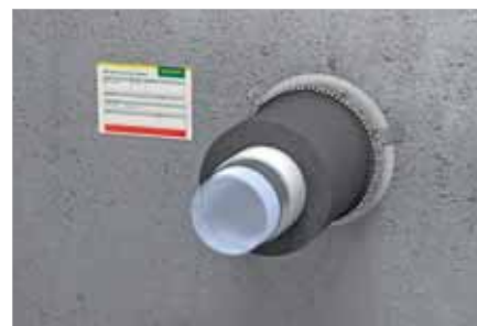
Vícevrstvé potrubí až do vnějšího průměru 110 mm s izolací ze syntetického kaučuku.
