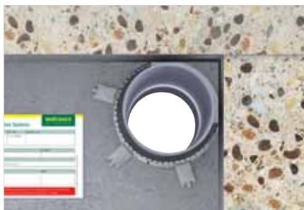
Vhodné pro rohové prostupy (2x protipožární manžety). Vzdálenost mezi stěnou a potrubím \leq 10 mm.
