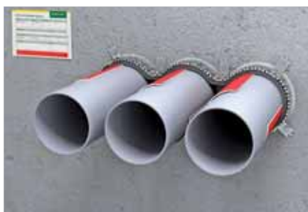
Vícenásobné prostupy (max. 3 potrubí přes 1 protipožární manžetu). Vzdálenost mezi potrubím \leq 15 mm.
