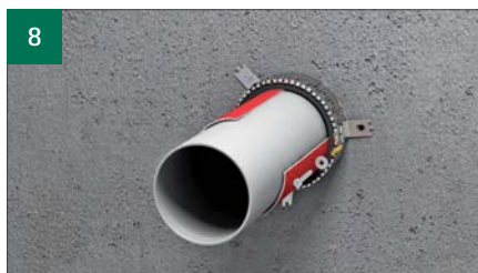
8 Fäst på väggen eller golvet med de medföljande pluggarna och skruvarna. I Gips väggar använd genomgående, gängstänger M6 eller M8.
