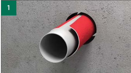
1 Montera röret och om så önskas tillsatt isolering.
