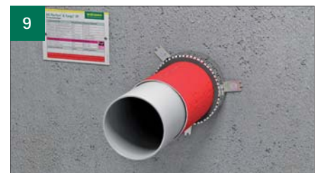
9 Applicera ett BIS Pacifyre® ID-kort på väggen eller golvet för identifiering av kontrollorgan.
