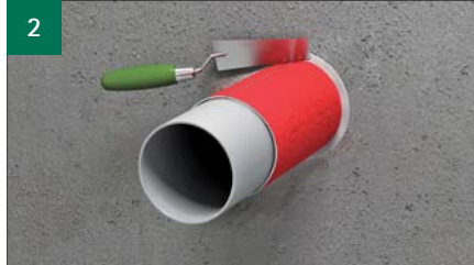
2 Se till att det ringformiga utrymmet runt röret är ordentligt förseglat och rök tätt med BIS Pacifyre® FPM murbruk eller motsvarande.
