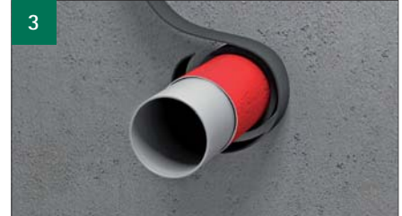
3 Linda brandremsa (och isolering) runt röret (observera antalet skikt som krävs*). Fäst med ett överlapp av 20 mm.
