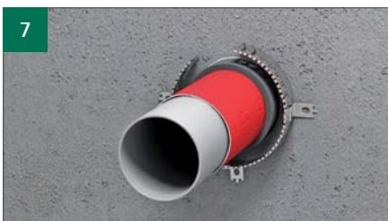
7 I slutet av de rostfria bandet böj 2 flikar. Placera ändarna över varandra och vik tillbaka flikarna på plats för att låsa stålbandet.
