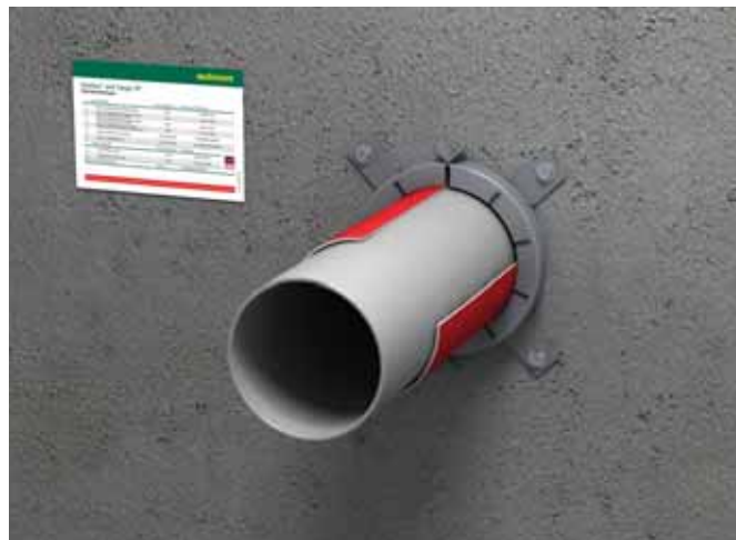
6. Vyplňte ID kartu a upevnite ju vedľa utesneného prístupu.
