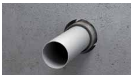
4. Zasuňte manžetu do otvoru a vycentrujte ju.
