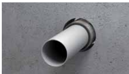
4. Zasuňte manžetu do otvoru a vycentrujte ji.
