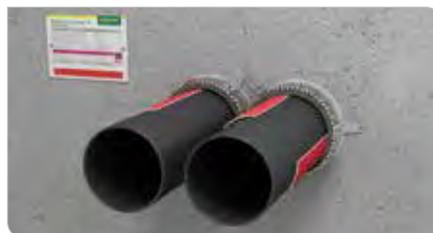
Nullabstand gedämmte Rohre
