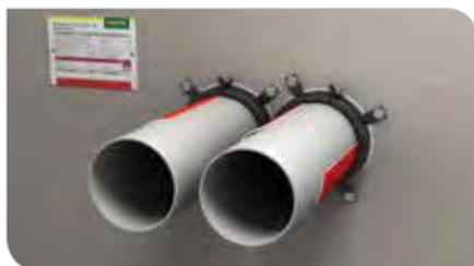
Nullabstand in leichten Trennwänden und Massivbauteilen
