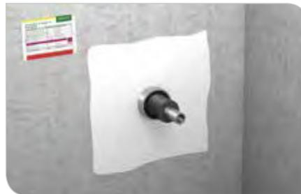
Nicht brennb. Rohr mit brennb. Dämmung.
