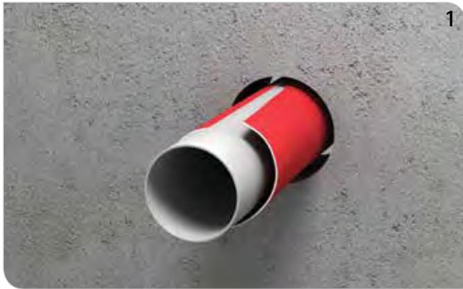
Rohrleitung (ggf. mit PE-Schallschutzschlauch) durchführen.
