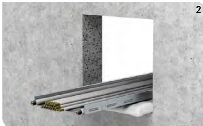
Nach Möglichkeit die erste Lage BIS Pacifyre® IWC Brandschutzkissen unter die Kabeltraverse oder das Kabelbündel platzieren.
