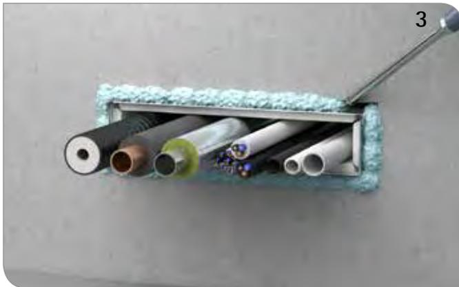
Restspalt rauchgasdicht (mit z. B. BIS Pacifyre® FPM Brandschutzmörtel oder Soudafoam Gun B1) verschließen.
