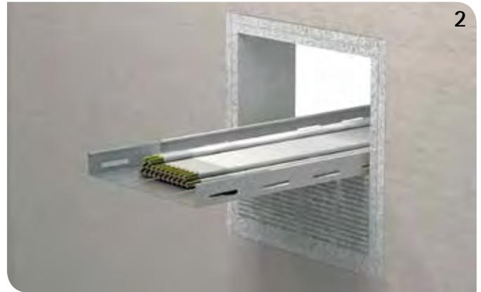
Kabel und Kabelpritsche mit BIS Pacifyre® MP Brandschutzbeschichtung versehen und BIS Pacifyre® MP Platten beidseitig an das Bauteil anpassen.
